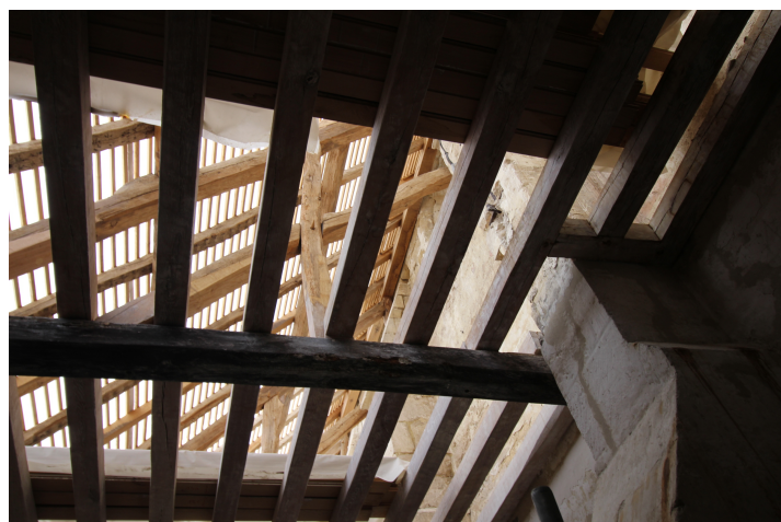
Charpente restaurée du collatéral sud avant pose du parquet et de la couverture.
