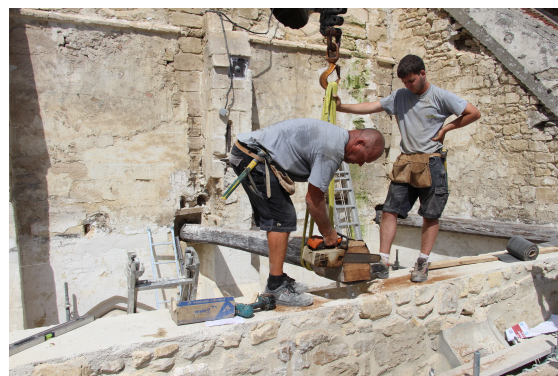
Les poutres tirants, déposées de la nef, sont ici récupérées pour être utilisées en tant que supports pour le plancher du collatéral sud
