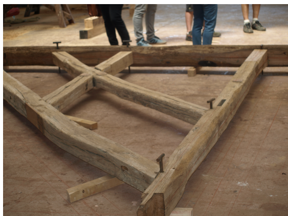
Restauration d'une des fermes de la charpente du collatéral sud en atelier
