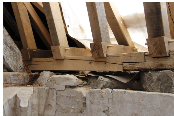
En cours de restauration sur place
