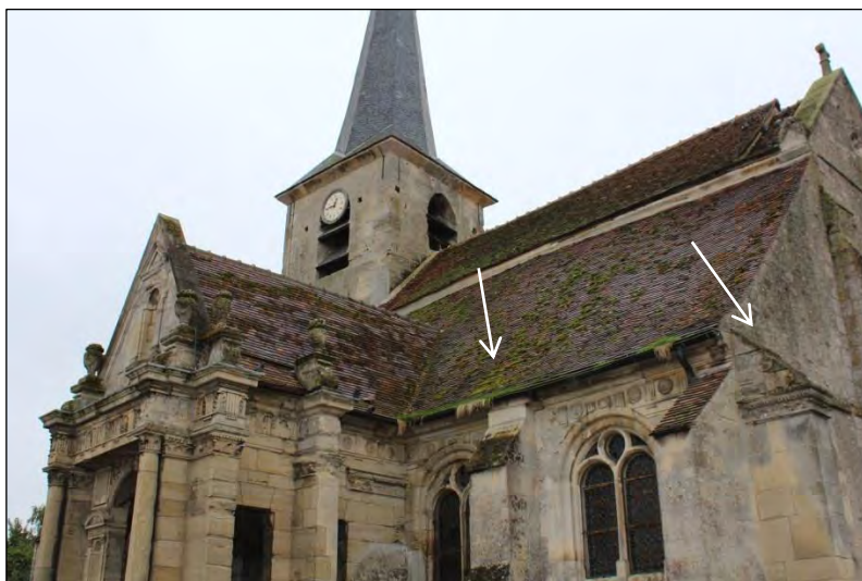
Parties XVIe siècle : porche d'entrée et collatéral Nord. Contrefort XVIe siècle destiné à recevoir pinacle et arc-boutant.
