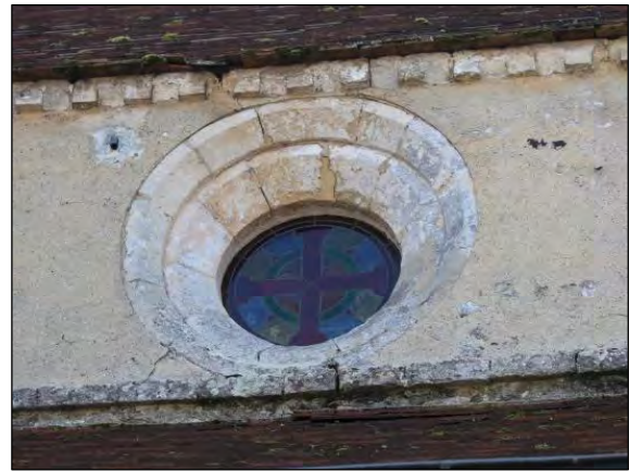
A gauche : deux roses de la nef côté Sud. A droite : une rose côté Nord. On remarque la corniche à modillons et le cordon en pierre protégeant le faitage de l'appentis du collatéral. Les baies sont munies de vitraux, placés dans une feuillure intérieure. L'ébrasement extérieur comporte une feuillure, comme à Livilliers.
