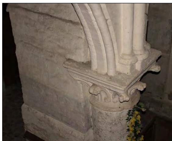
Détails des piles monocylindriques de la nef (travée 6, pile Nord) : base et chapiteau, profil des arcs.
