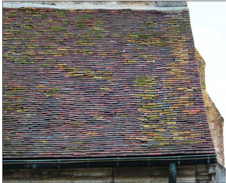
Détails de la couverture : en pied de versant, elle est très ondulée et commence à se désorganiser. Les tuiles anciennes sont groupées ensemble ; elles sont écaillées sur le dessus et accrochent les mousses.
