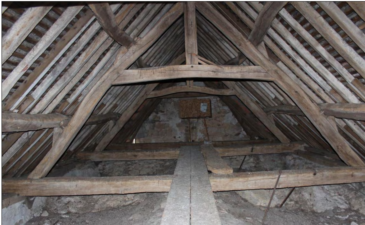
Fermes anciennes en bon état, présence de sablières, chevrons faibles doublés notamment en pied, liteaux récents.
