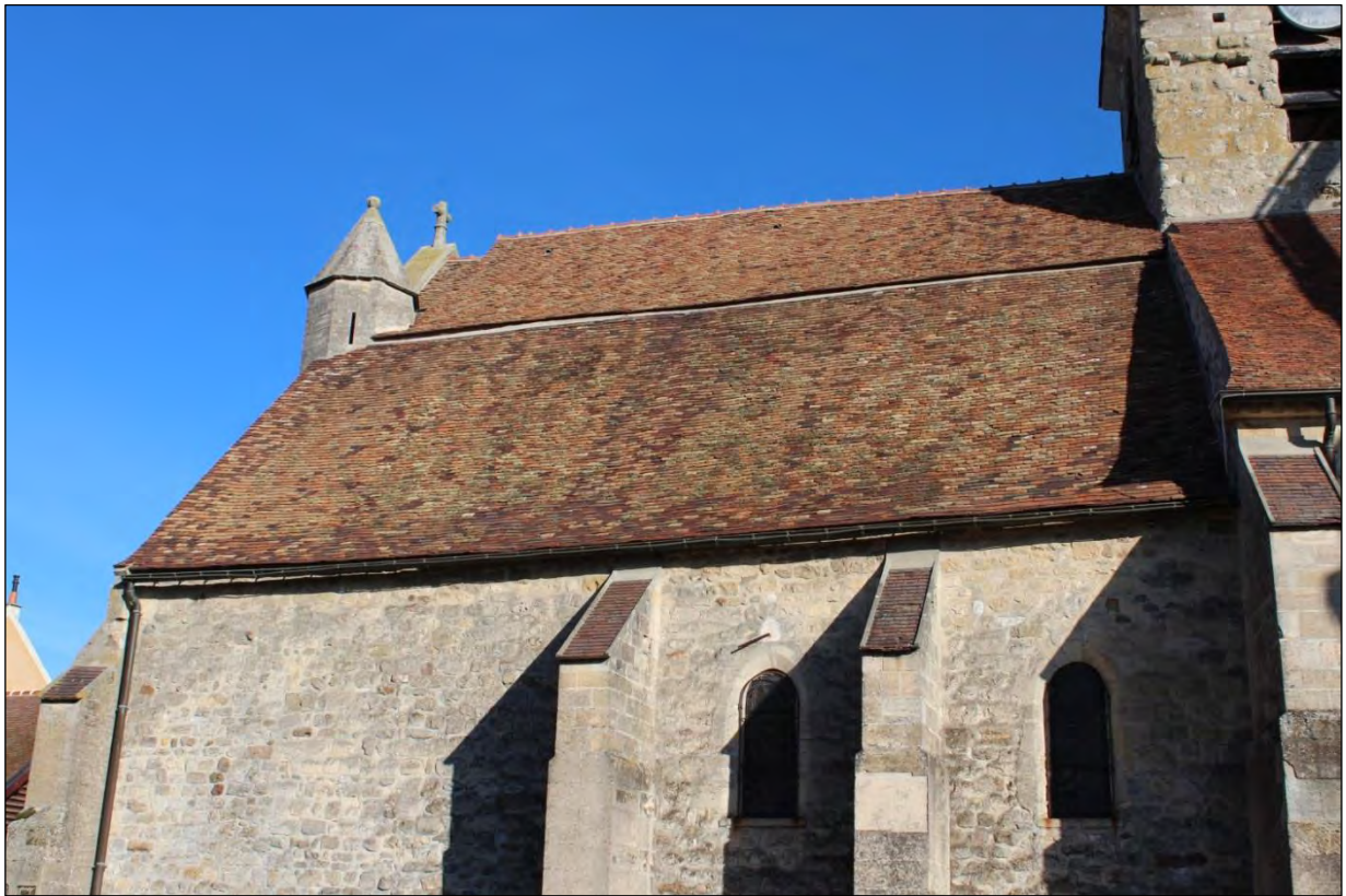
Vue d'ensemble de la couverture du collatéral Sud. La couverture est un mélange de tuiles anciennes et modernes. Les glacis des contreforts sont couverts en tuiles modernes scellées, les solins et les rives sont faits au ciment ; quelques tuiles sont cassées.
