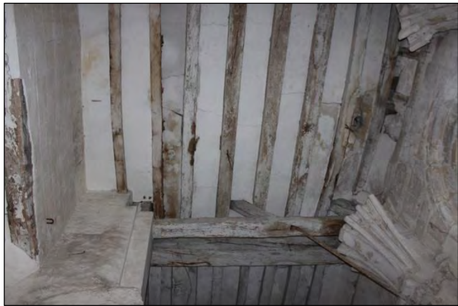
Travée 3, collatéral Nord. Les pieds de gerbe comportent le départ des doubleaux, des formerets, et de trois ogives au lieu d'une entre le doubleau et chaque formeret : les voûtes étaient donc prévues à liernes et tiercerons.
