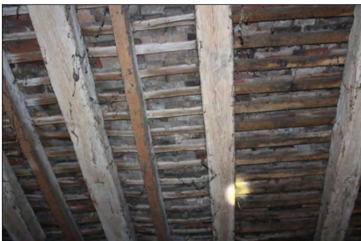
L'entraxe entre les chevrons anciens, trop important, a été recoupé par des tasseaux pour conforter les liteaux. A gauche ce sont des liteaux anciens en châtaignier, de faible section, très altérés par les infiltrations d'eau ; à droite des liteaux récents en chêne, de section plus importante. Le litelage a donc été en partie refait lors du dernier remaniage de la couverture (1974 ?).
