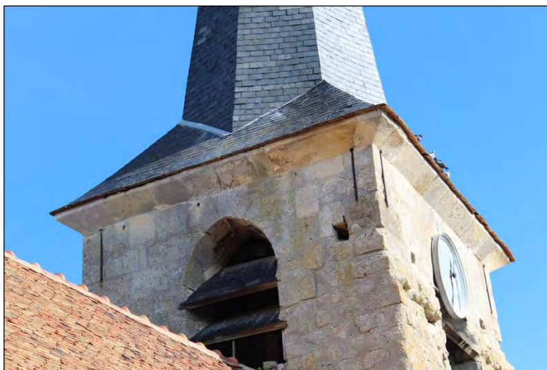
Pierres d'angle de la corniche instables, ici à l'angle Sud-Est. Abat-sons couverts en ardoises fines ; quelques ardoises manquantes.
