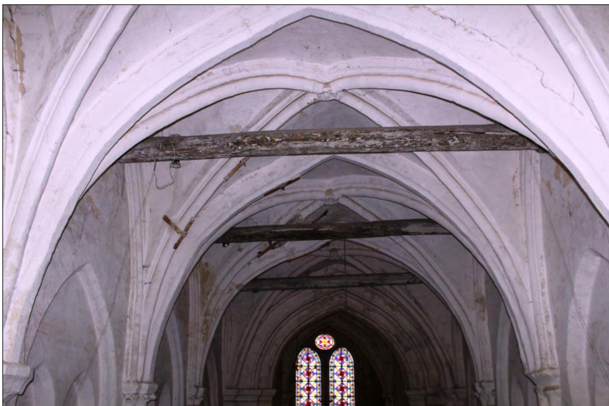
Vue de la nef vers le chevet, travées 5, 4, 3. Tirants en bois au milieu des travées : poutres de 30 x 30 cm.
