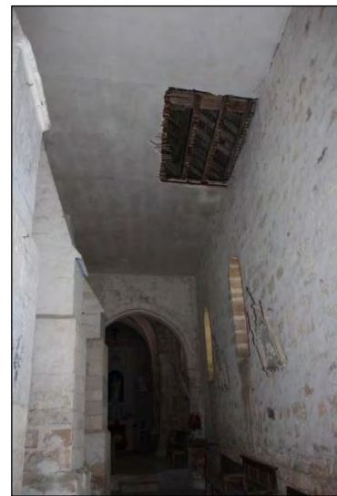
Partie effondrée du plafond du collatéral Sud de la nef.
