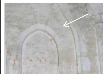
Ce décor recouvre les murs, gouttereaux et pignons, et les contreforts. Il recouvre les baies du triforium obturées, sauf les deux baies les plus à l'Est dans la travée 3, dont l'arc est au contraire souligné par ce décor de faux-joint. Il correspond donc à une époque où la charpente des collatéraux était apparente. On retrouve ce décor dans la nef.
