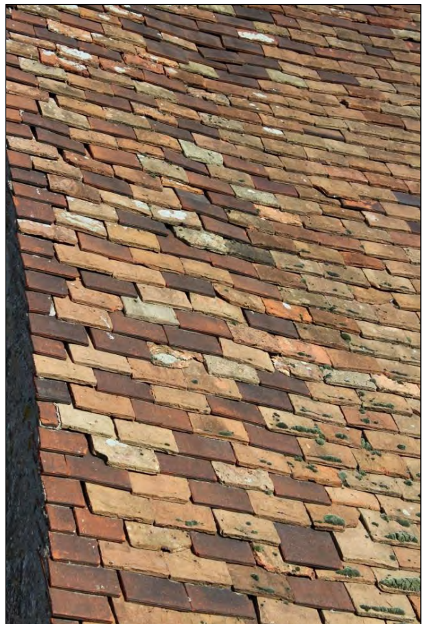
Le versant est ondulé : affaissement des liteaux entre les chevrons, fléchissement des chevrons vers le milieu. Les tuiles anciennes sont poreuses, écaillées sur le dessus, beaucoup sont cassées voire manquantes.
