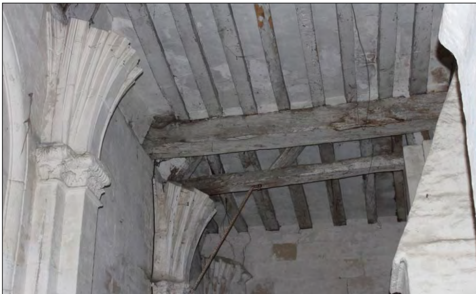
Entrail de ferme, solives en appui sur le dessus de l'entrait, entrait de la contrefiche située au droit du contrefort déversé entre les travées 3 et 4.
