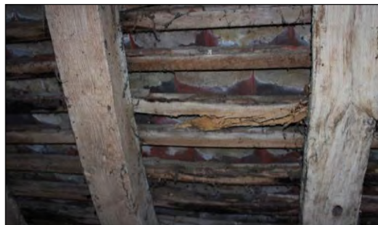
Détail des liteaux pulvérulents et du dessous des tuiles, qui laissent passer l'eau.
