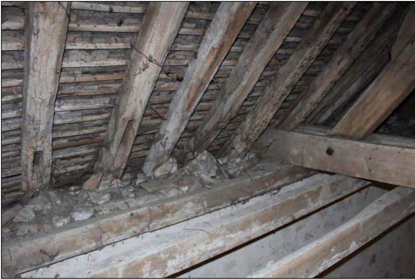
Les chevrons sont anciens, certains comportent des mortaises à différentes hauteurs, suggérant qu'ils ont été réemployés. Par endroits ils sont trop espacés et fléchissent. Le lattis en chêne est ancien.
