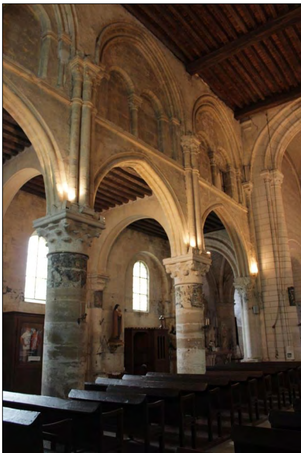
Eglise d'Ennery. Vues de l'élevation de la nef côté Nord, du triforium aveugle, et du mur au revers, dans le comble du collatéral. La dernière baie du mur Nord comporte une baie de service, permettant d'accéder au comble du collatéral.
