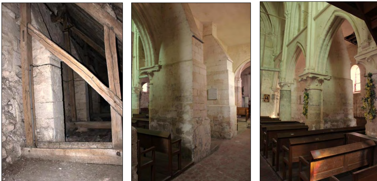
Contreforts de la nef côté Sud, en haut dans le comble et en bas dans le collatéral.
