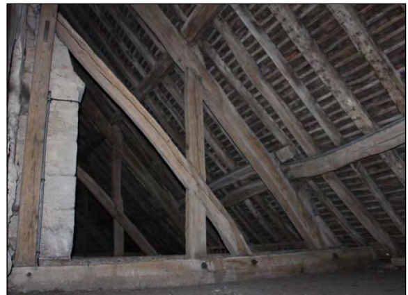
Charpente du collatéral Sud.
