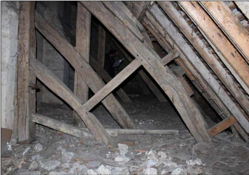
Contrefiche en charpente dans le collatéral Nord
