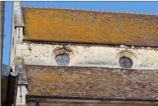
A gauche : deux roses de la nef côté Sud. A droite : une rose côté Nord. On remarque la corniche à modillons et le cordon en pierre protégeant le faitage de l'appentis du collatéral. Les baies sont munies de vitraux, placés dans une feuillure intérieure. L'ébrasement extérieur comporte une feuillure, comme à Livilliers.
