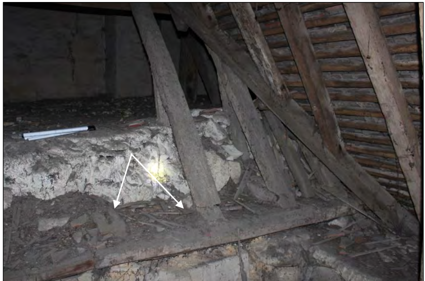
Sablère externe du collatéral, ancienne, visible ici au droit du comble du porche d'entrée Nord. About d'entrait, blochets, jambes de force, remplissage en plâtras fermant l'espace du collatéral entre chaque.
