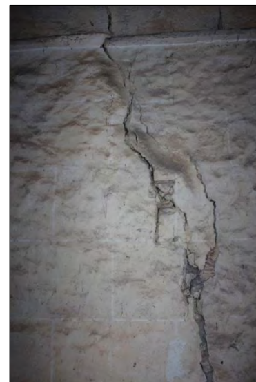
Dans les combles des collatéraux : les murs sont badigeonnés au lait de chaux, un faux appareil peint au trait blanc.
