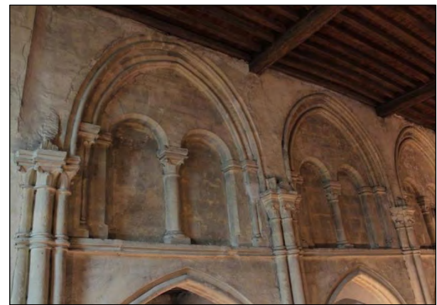
Eglise de Santeuil. Elévation à trois niveaux de la nef. Intérieur de la galerie du triforium, en charpente, au revers des arcatures en pierre.
