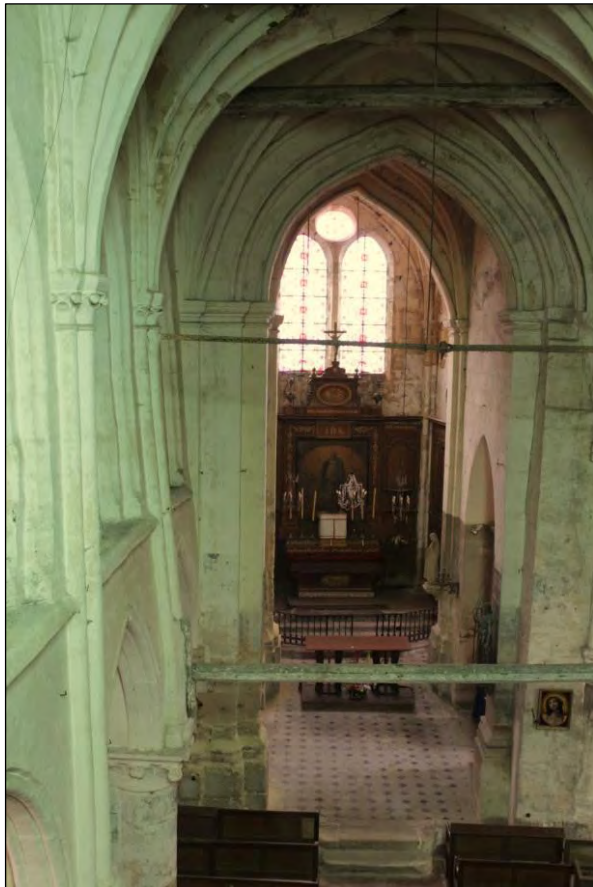
Les pilastres doriques du clocher soulignent le dévers ancien du mur gouttereau de la nef dans la travée 3.
