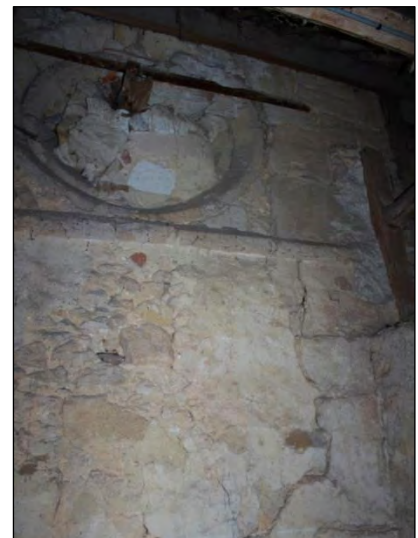
Ancre en fers plats. A gauche collatéral Sud, travée 5, à droite collatéral Nord, travée 3.
