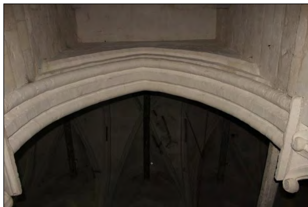
Travée 3, côté Sud
