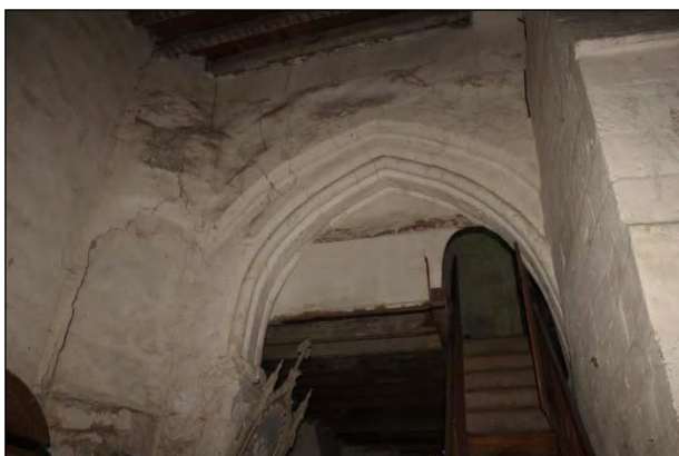
Travée 6, côté Sud. A gauche la tourelle d'escalier.
