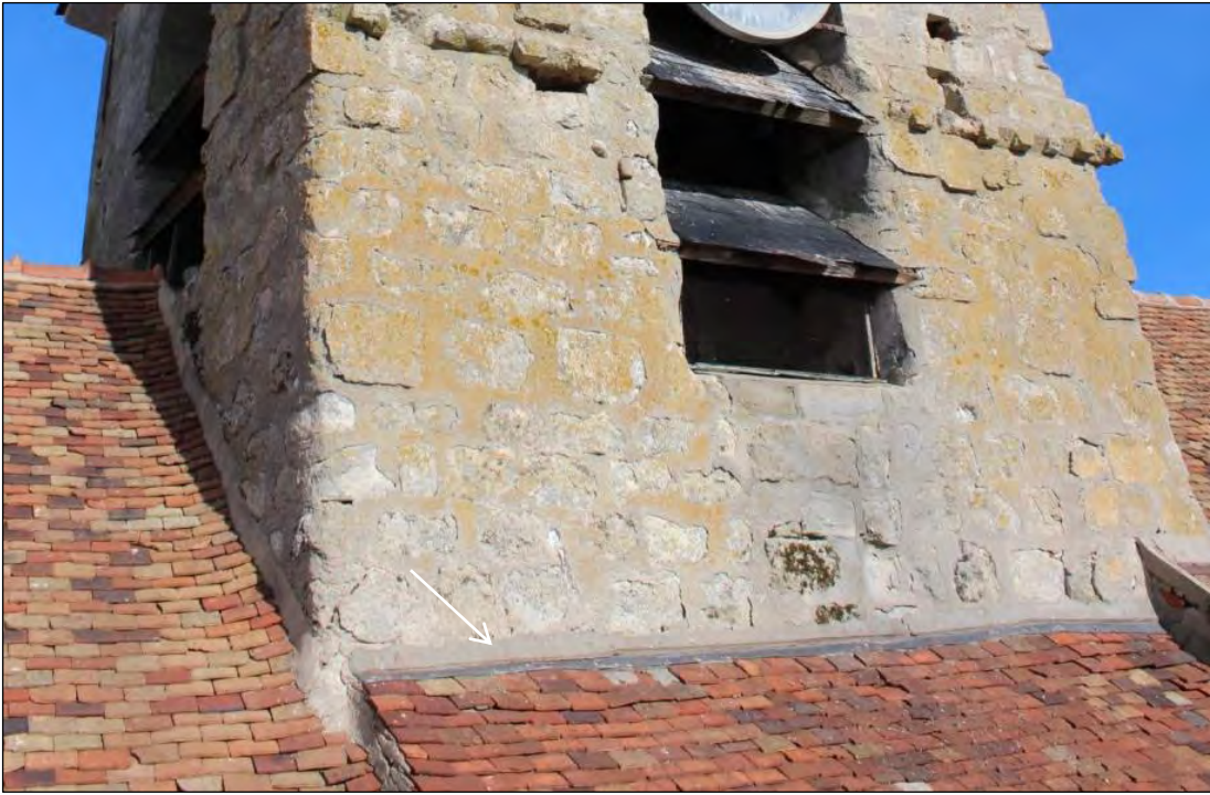
Faîtage contre clocher (bande de zinc engravée et solin au mortier).
