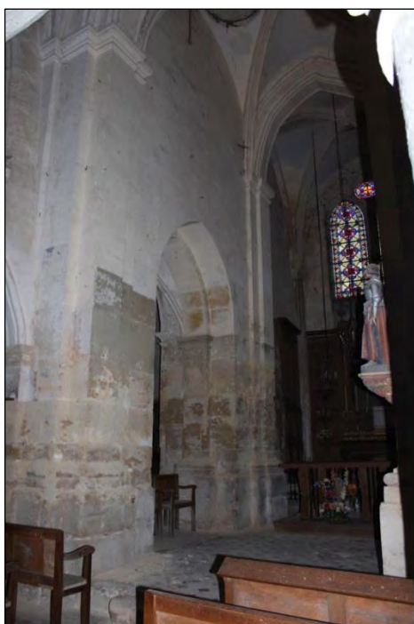
Travée sous le clocher. Déformation de l'arc s'ouvrant sur la travée du chevet.
