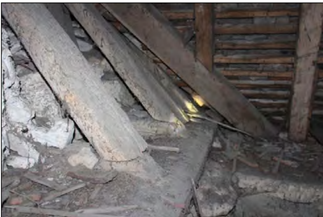
Détail de la charpente du collatéral Nord : sablière ancienne, visible au droit du comble du porche d'entrée.
