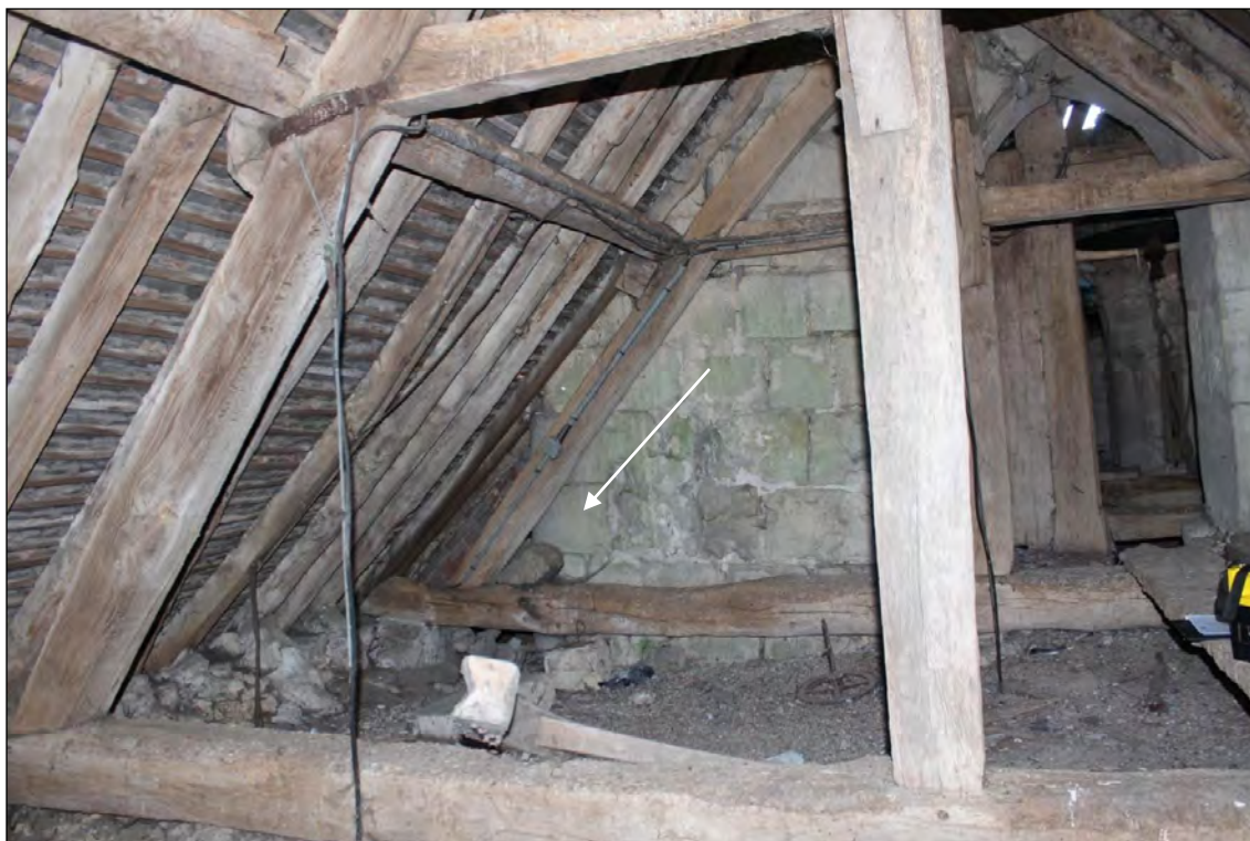
Rive Sud-Ouest infiltrante : les chevrons de rive et le pied de ferme ont pris l'eau. Absence de sablière. Fléchissement des chevrons.
