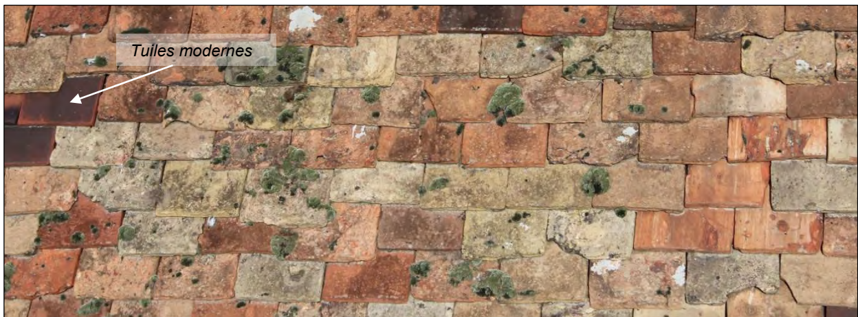
Détail des tuiles, collatéral Sud de la nef.
