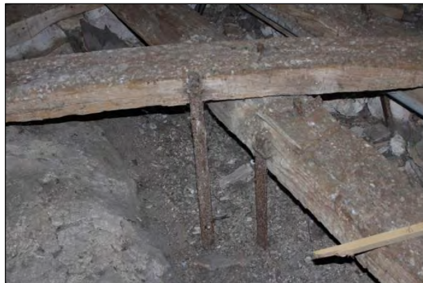
Ancrages sur les entrants de ferme
