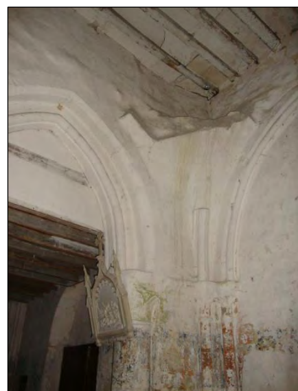
Travée 6, côté Nord.
