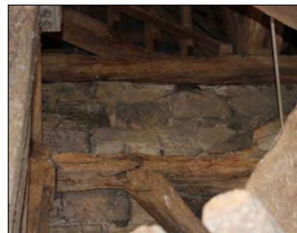
Détail de la sablière et d'un chapeau du beffroi.
