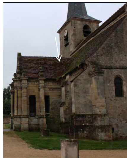
Parties XVIe siècle : porche d'entrée et collatéral Nord. Contrefort XVIe siècle destiné à recevoir pinacle et arc-boutant.
