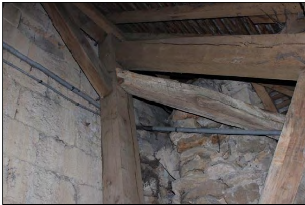
Détails des charpentes restaurées.
