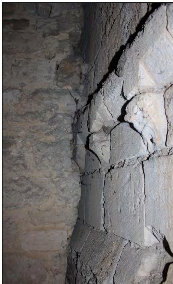
Comble du collatéral Sud : partie en talus du mur Sud du clocher, corniche à modillons, vestiges du clocher roman. Les autres maçonnerie sont rapportées contre.
