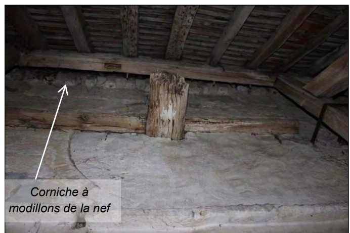
Rose du mur Sud, travée 6. Ancien solin de faîtage et corniche à modillons de la nef.
