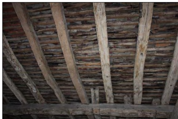
Panne, chevrons anciens. Les liteaux sont exposés à l'humidité.
