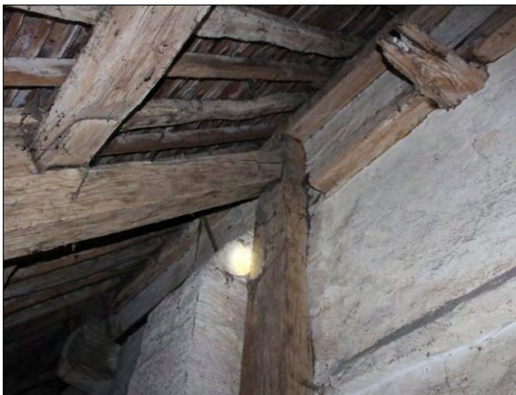
▲ Panne faîtière : dans les travées 5 et 6 elle est en appui sur les poinçons et semble en bon état vue de dessous. Dans les travées 3 et 4 la faîtière pourrie a été doublée par une panne en appui sur l'arbalétrier. ▶
