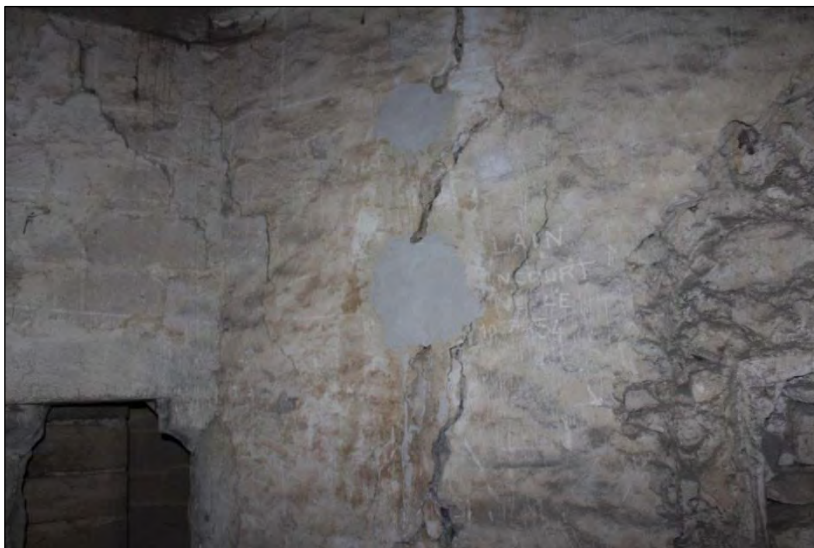
Dans les combles des collatéraux : les murs sont badigeonnés au lait de chaux, un faux appareil peint au trait blanc.
