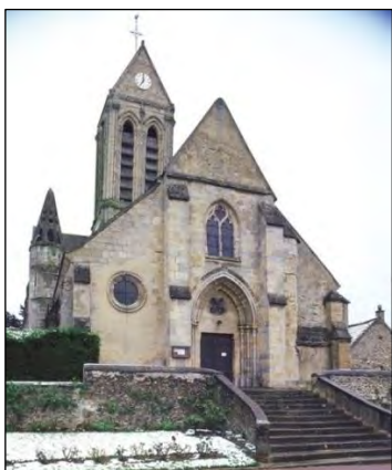
Eglise de Grisy-les-Plâtres, Val d'Oise (début du XIIIe siècle). Les combles des collatéraux ont été rehaussés, leurs pignons occidentaux de même et la façade occidentale modifiée en fonction.
