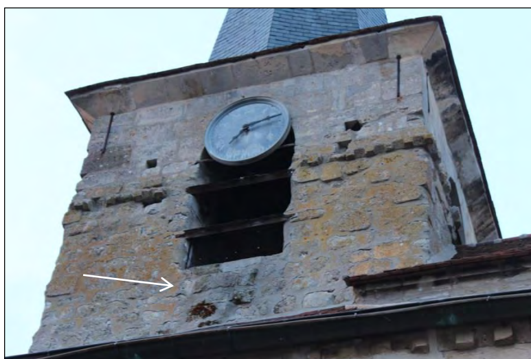
Détails de la face Sud de la tour : le mur a été reconstruit au-dessus de la corniche à modillons. Base d'une colonnette sur l'angle,
