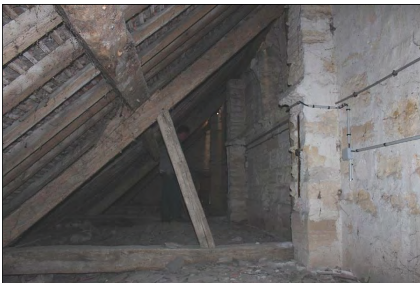
Grisy-les-Plâtres. Dans les combles des collatéraux, on remarque le cordon en pierre marquant l'ancienne hauteur des toits, sur les murs et sur les contreforts. A droite : détail de l'une des roses, côté nef.
