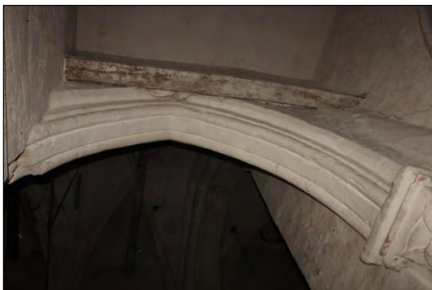
Travée 4, côté Sud
