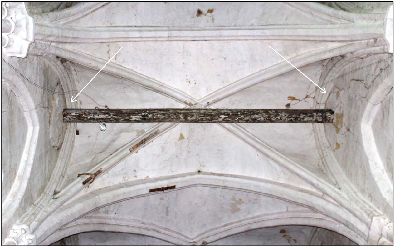
Voûtes de la nef, travée 5. Le réseau de fissures souligne les contours des roses bouchées en maçonnerie.
