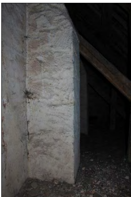
Ce décor recouvre les murs, gouttereaux et pignons, et les contreforts. Il recouvre les baies du triforium obturées, sauf les deux baies les plus à l'Est dans la travée 3, dont l'arc est au contraire souligné par ce décor de faux-joint. Il correspond donc à une époque où la charpente des collatéraux était apparente. On retrouve ce décor dans la nef.
