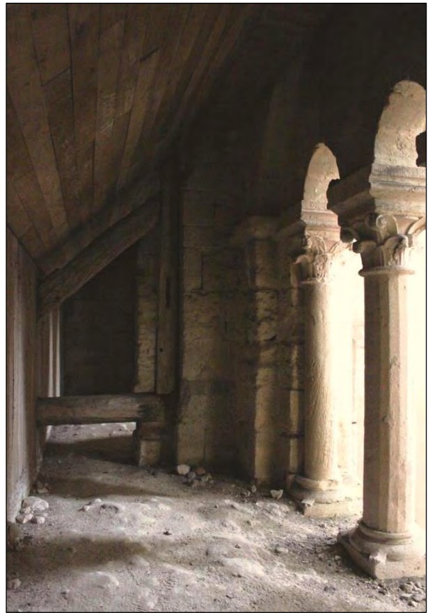
Eglise de Santeuil. Elévation à trois niveaux de la nef. Intérieur de la galerie du triforium, en charpente, au revers des arcatures en pierre.
