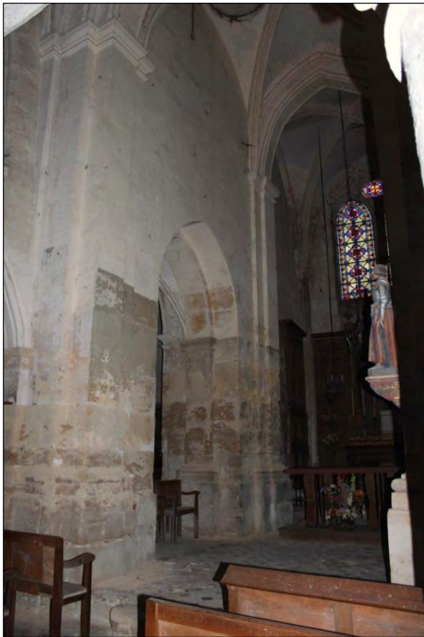
Photo de gauche : piliers du clocher rebâti en sous-œuvre, fin XVIIe ou première moitié du XVIIIe siècle. Photo de droite : dans le collatéral Sud, juxtaposition des pilastres classiques et des piles composées, les piliers du chœur n'ont été rebâti que partiellement et les voûtes ont conservé leurs supports gothiques, contrairement à celles du collatéral Nord du chœur (ci-dessous).
