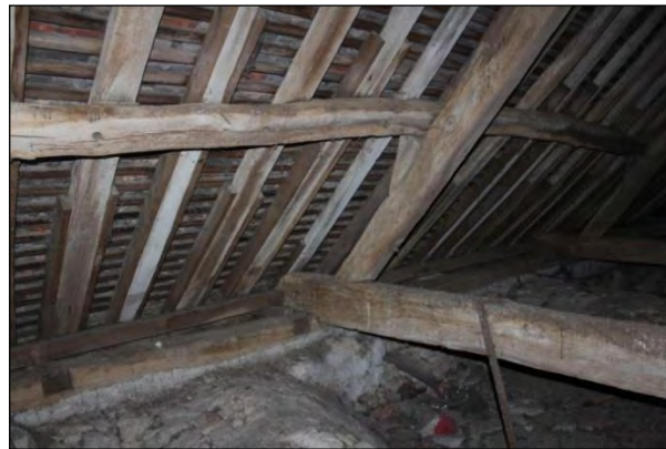
Chevrons doublés en pied lors de la restauration de 1987. Sablière interne sous les entrails, sablière externe rapportée d'un entrail à l'autre.
