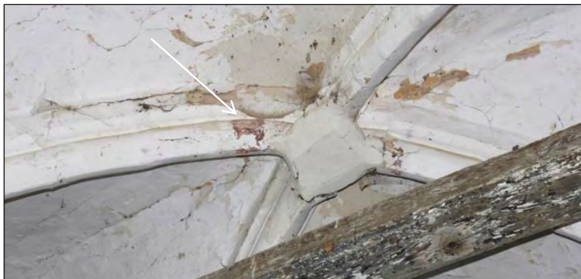
Le badigeon des voûtes de la nef, écaillé, laisse voir des traces ocre jaune sur les voûtains et ocre rouge sur les nervures.
