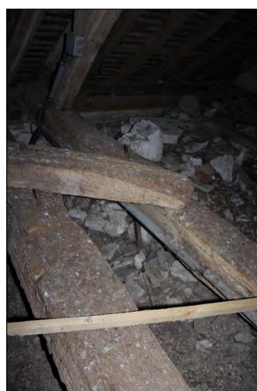
Ancrages sur les entrants de ferme
