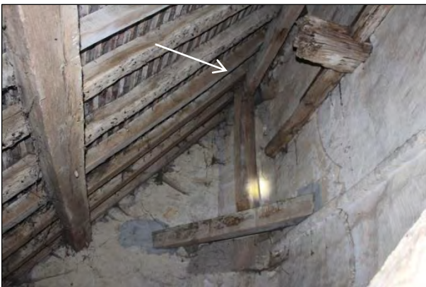
Autre appui du faîtage, placé en avant de l'ancienne corniche de la nef. Les assemblages poinçon-arbalétriers des fermes sont renforcés par des cerclages métalliques.
