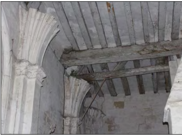
Travée 3, collatéral Nord. Les pieds de gerbe comportent le départ des doubleaux, des formerets, et de trois ogives au lieu d'une entre le doubleau et chaque formeret : les voûtes étaient donc prévues à liernes et tiercerons.
