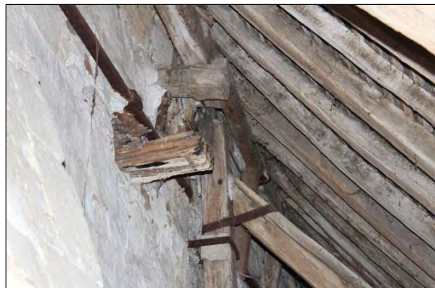
Autre appui du faîtage, placé en avant de l'ancienne corniche de la nef. Les assemblages poinçon-arbalétriers des fermes sont renforcés par des cerclages métalliques.
