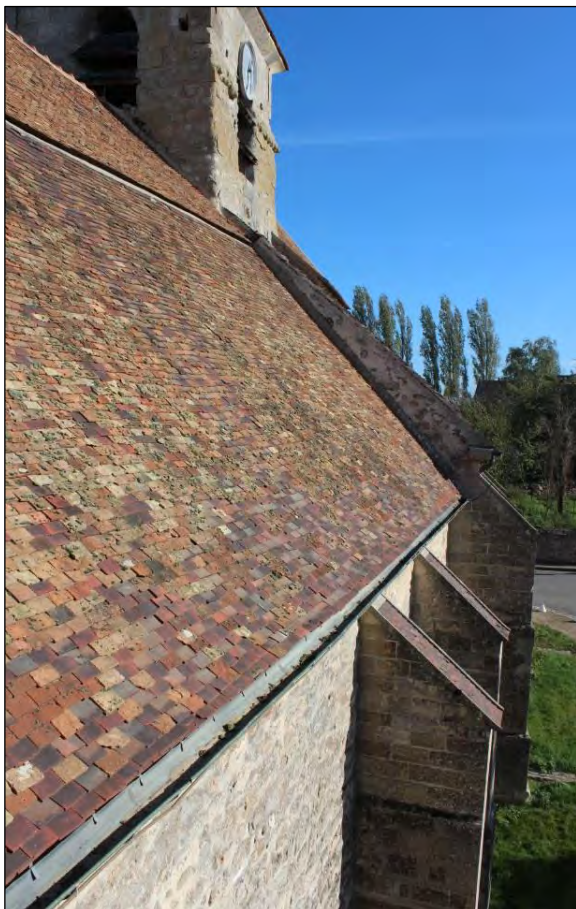
Le versant est ondulé : affaissement des liteaux entre les chevrons, fléchissement des chevrons vers le milieu. Les tuiles anciennes sont poreuses, écaillées sur le dessus, beaucoup sont cassées voire manquantes.
