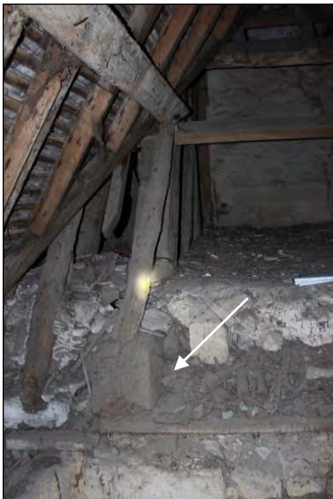
Sablère externe du collatéral, ancienne, visible ici au droit du comble du porche d'entrée Nord. About d'entrait, blochets, jambes de force, remplissage en plâtras fermant l'espace du collatéral entre chaque.
