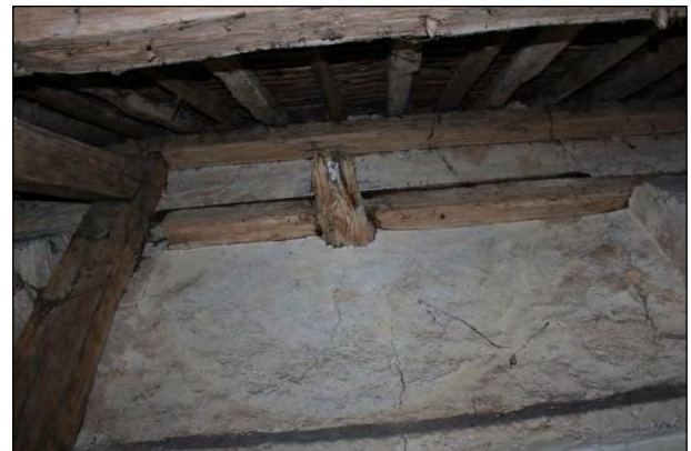
Ancre en bois. A gauche collatéral Sud, travée 6, à droite collatéral Nord, travée 5.
