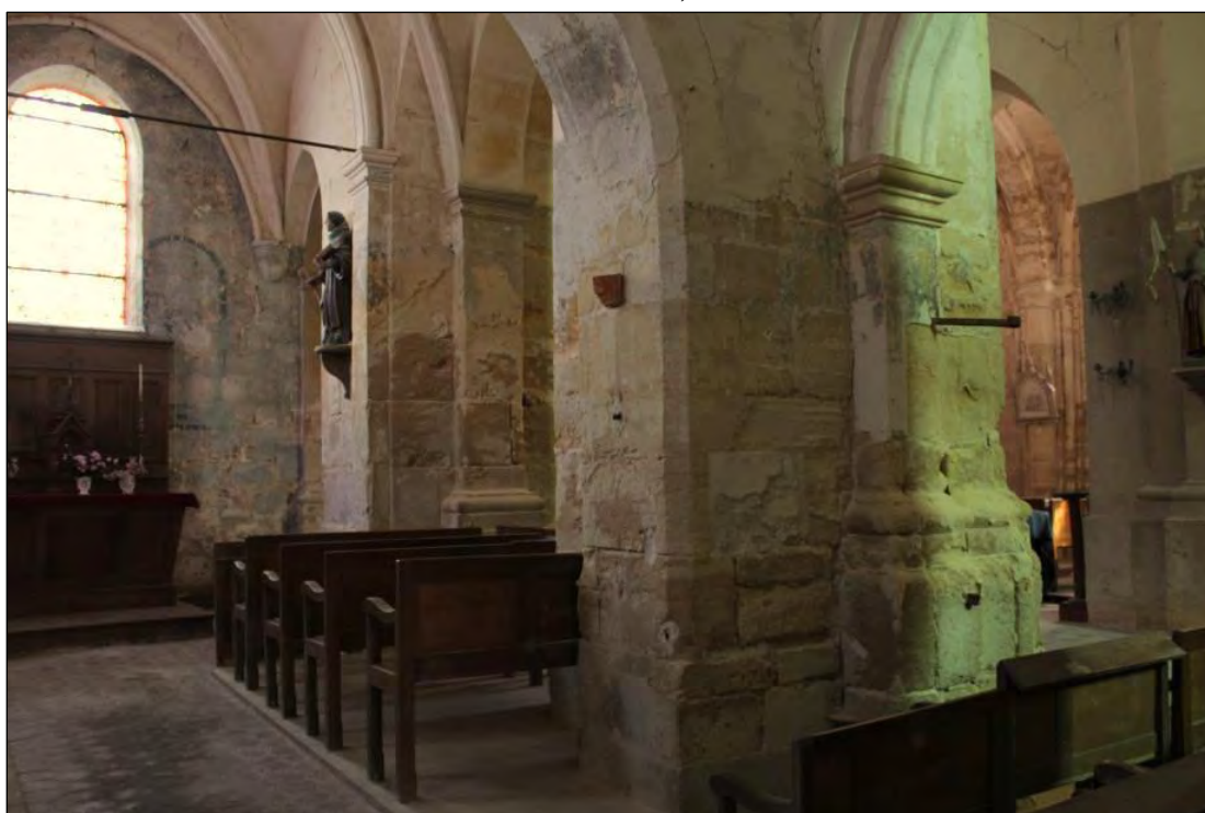
Mêmes piles au revers, dans le collatéral Nord. Au premier plan : la première travée de la nef.
