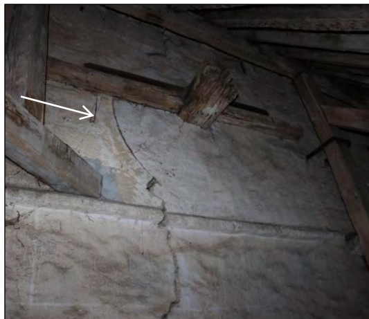
Rose du mur Sud, travée 6. Ancien solin de faîtage et corniche à modillons de la nef.
