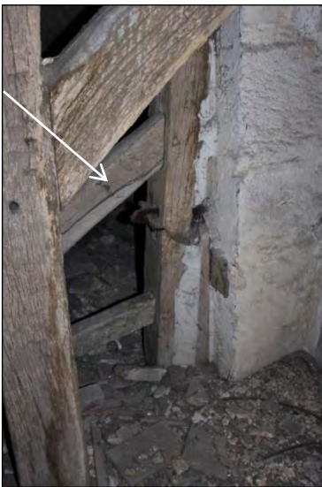
Détail : ancre du tirant métallique traversant le contrefort
