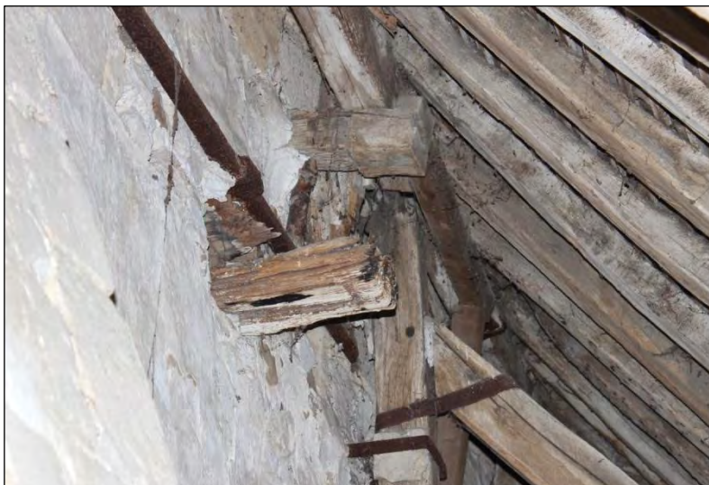
Ancre en fers plats. A gauche collatéral Sud, travée 5, à droite collatéral Nord, travée 3.
