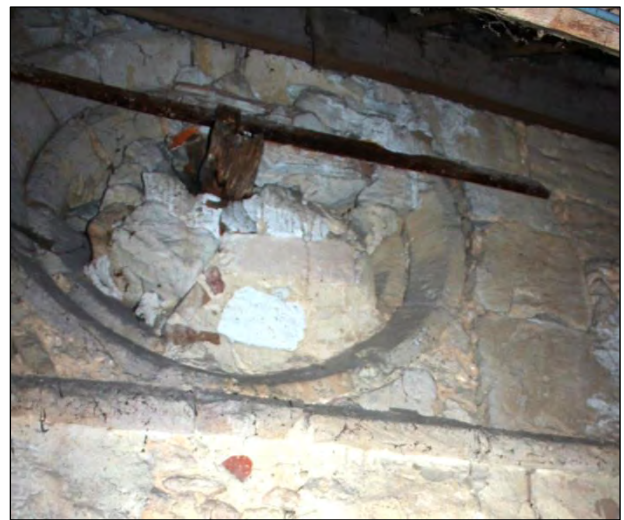
Dans les combles des collatéraux, au revers des murs gouttereaux de la nef : roses de la nef bouchées en maçonnerie, et anciens solin de faîtage en pierre des toits des collatéraux. A droite : la rose de la travée 3.
