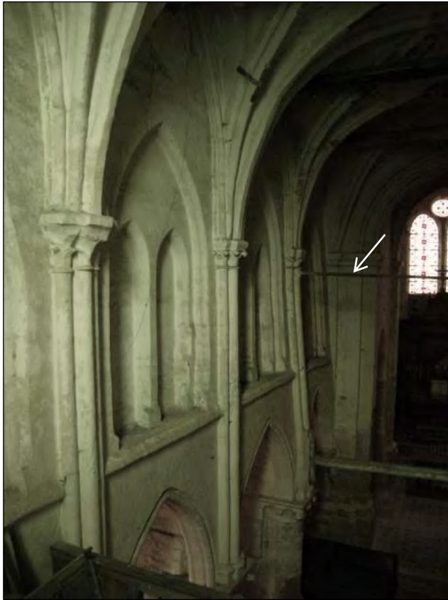
Déformation maximale : support entre travée 3 et travée 4
