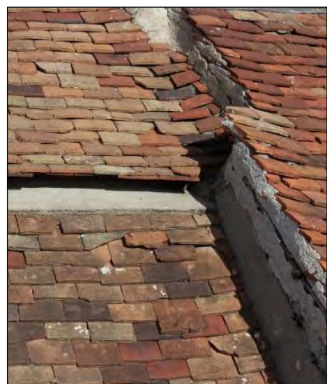
Détails de la même rive latérale, solin au mortier fissuré en haut.
