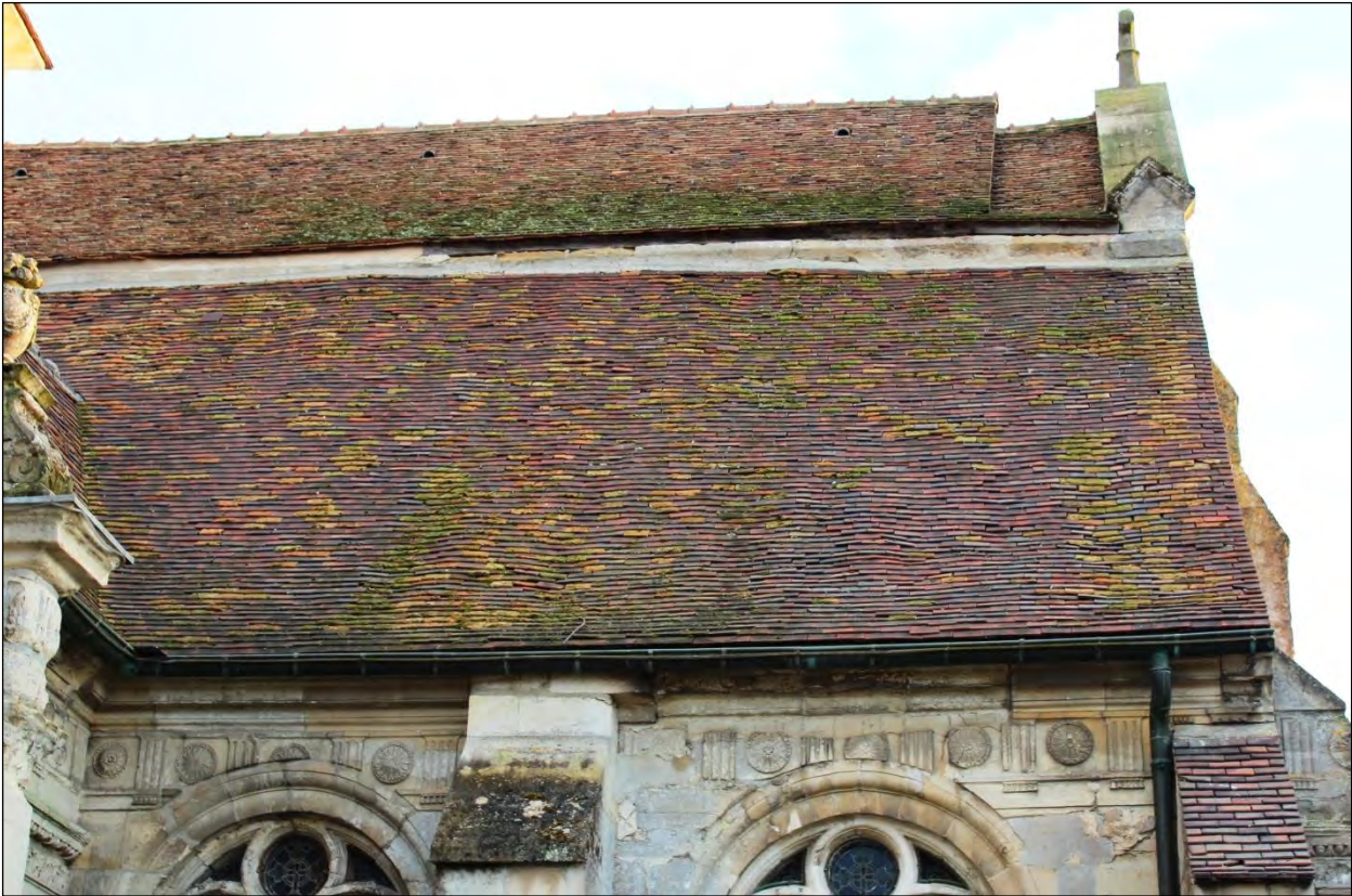
Couverture ondulée d'un chevron à l'autre, affaissement des liteaux. Photos mars 2014.
