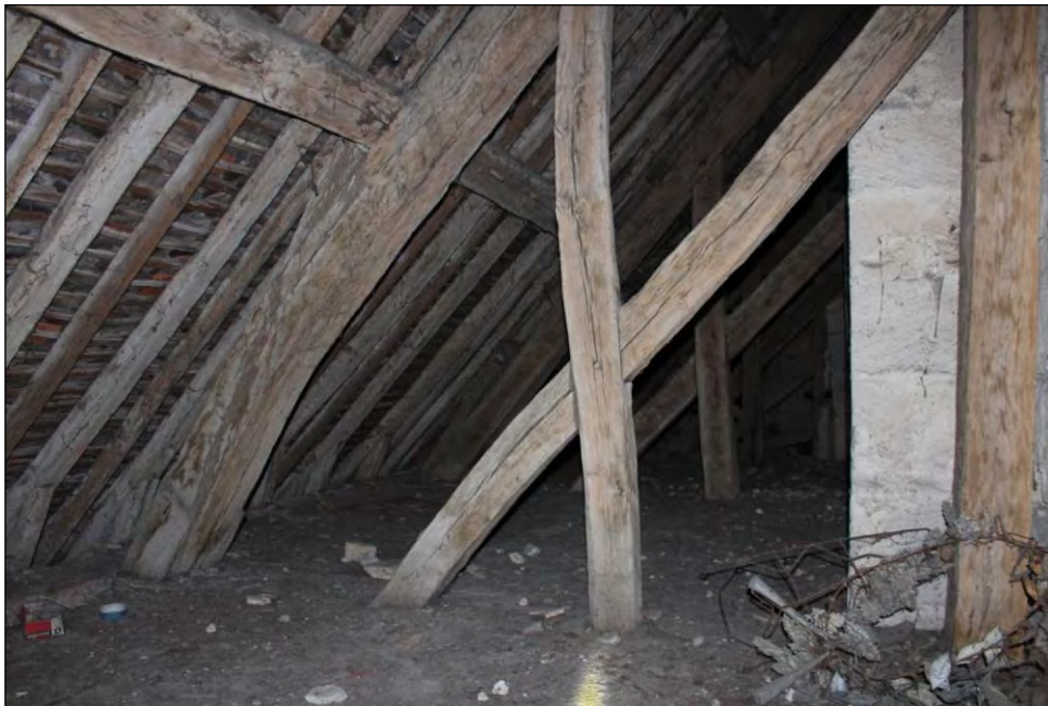
Les entrails de ferme sont au-dessous du plancher et du solivage, posé dessus postérieurement.
