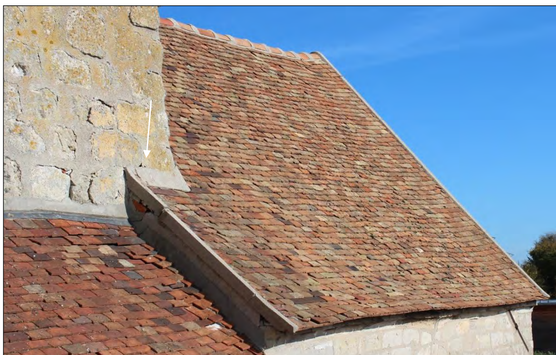
Vue d'ensemble de la couverture du chevet, versant Sud. Infiltration au niveau de la rive désorganisée, solin au mortier fracturé.
