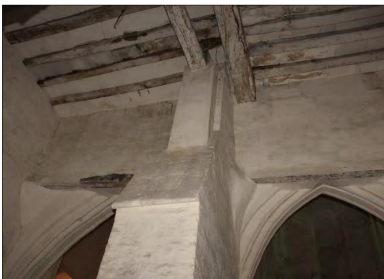
Travées 3 et 4, côté Nord.
