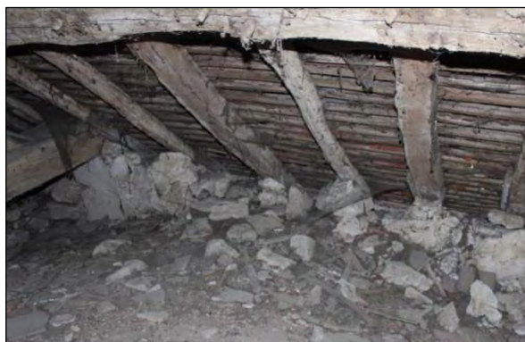
Absence de sablière
