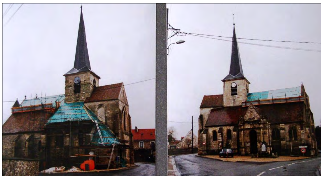
Travaux de couverture en 1987.
