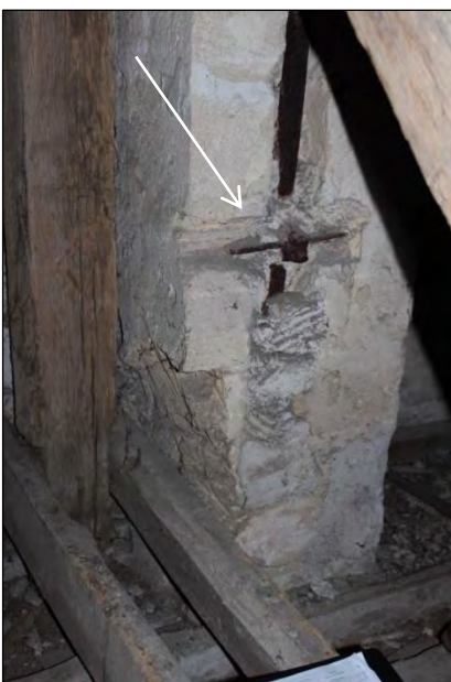
Ancre symétrique côté Sud. Le bloc de pierre du contrefort a été entaillé.
