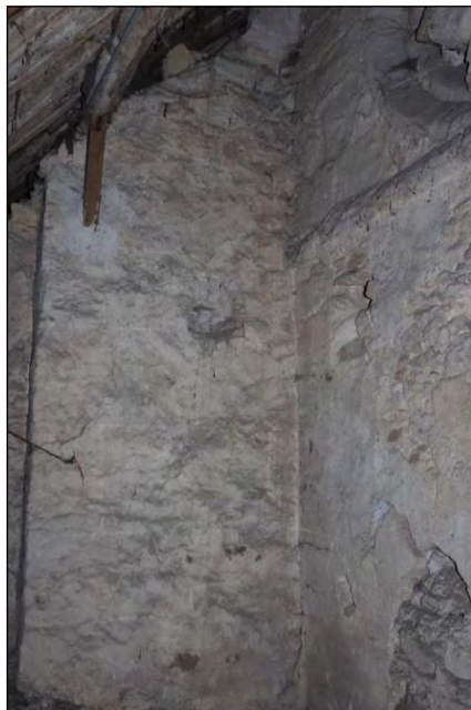
Ce décor recouvre les murs, gouttereaux et pignons, et les contreforts. Il recouvre les baies du triforium obturées, sauf les deux baies les plus à l'Est dans la travée 3, dont l'arc est au contraire souligné par ce décor de faux-joint. Il correspond donc à une époque où la charpente des collatéraux était apparente. On retrouve ce décor dans la nef.
