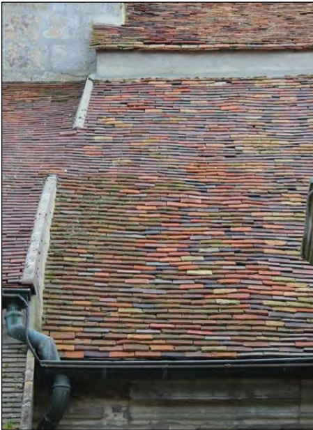
Détails de la couverture : en pied de versant, elle est très ondulée et commence à se désorganiser. Les tuiles anciennes sont groupées ensemble ; elles sont écaillées sur le dessus et accrochent les mousses.
