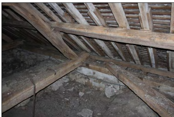
Chevrons doublés en pied lors de la restauration de 1987. Sablière interne sous les entrails, sablière externe rapportée d'un entrail à l'autre.
