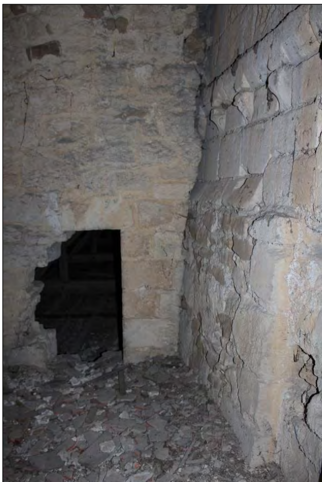
Comble du collatéral Sud : partie en talus du mur Sud du clocher, corniche à modillons, vestiges du clocher roman. Les autres maçonnerie sont rapportées contre.
