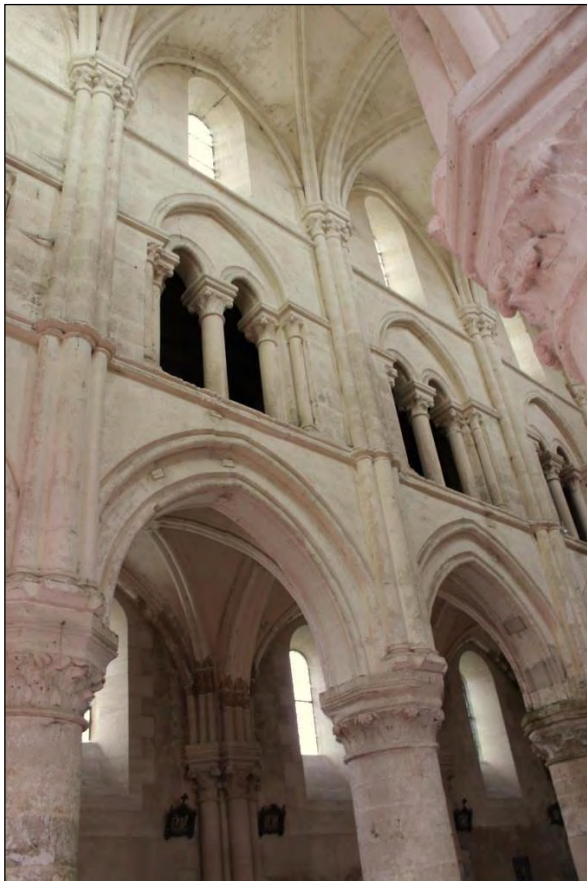
Eglise de Santeuil. Elévation à trois niveaux de la nef. Intérieur de la galerie du triforium, en charpente, au revers des arcatures en pierre.
