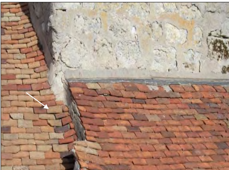
Détails de la même rive latérale, solin au mortier fissuré en haut.
