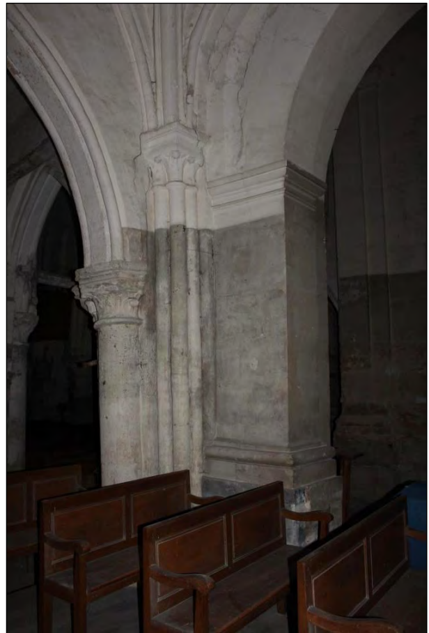
Photo de gauche : piliers du clocher rebâti en sous-œuvre, fin XVIIe ou première moitié du XVIIIe siècle. Photo de droite : dans le collatéral Sud, juxtaposition des pilastres classiques et des piles composées, les piliers du chœur n'ont été rebâti que partiellement et les voûtes ont conservé leurs supports gothiques, contrairement à celles du collatéral Nord du chœur (ci-dessous).
