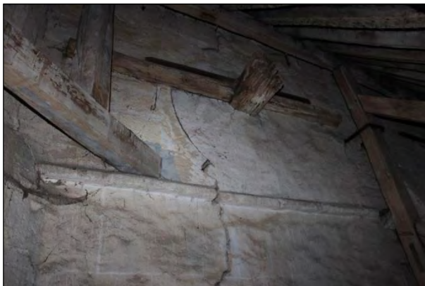
Ancre en bois. A gauche collatéral Sud, travée 6, à droite collatéral Nord, travée 5.
